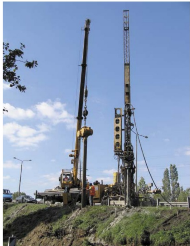
Fot. 5. Z lewej strony zabudowa zbrojenia przy użyciu wibromłota, z prawej – wykonywanie kolumny jet-grouting
