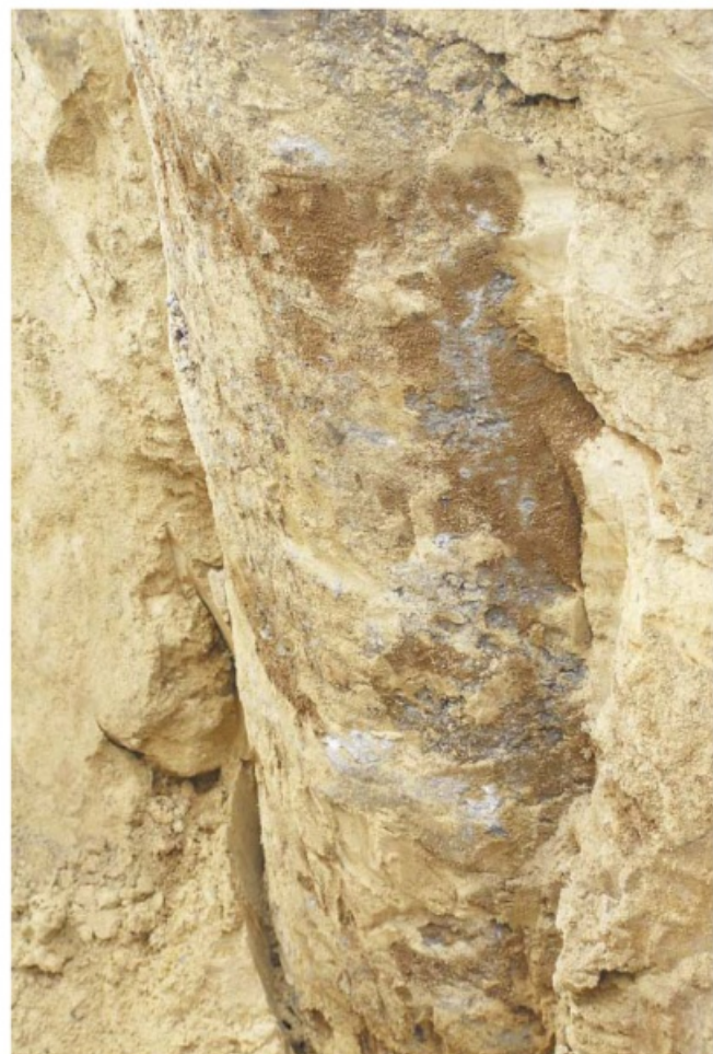
Fot. 3. Pal wiercony po wykonaniu odkrywki kontrolnej
