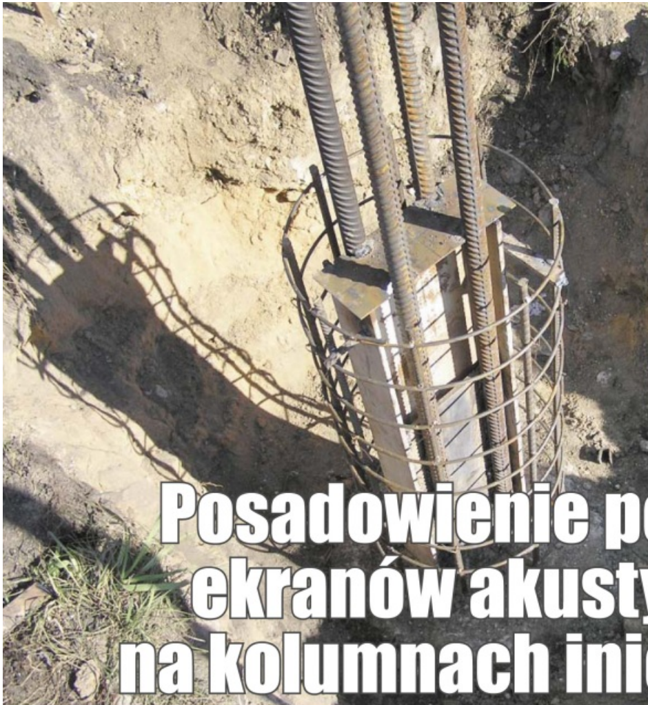
Fot. 1. Zbrojenie słupa ekranu połączone z palem Firmy Chrobok
