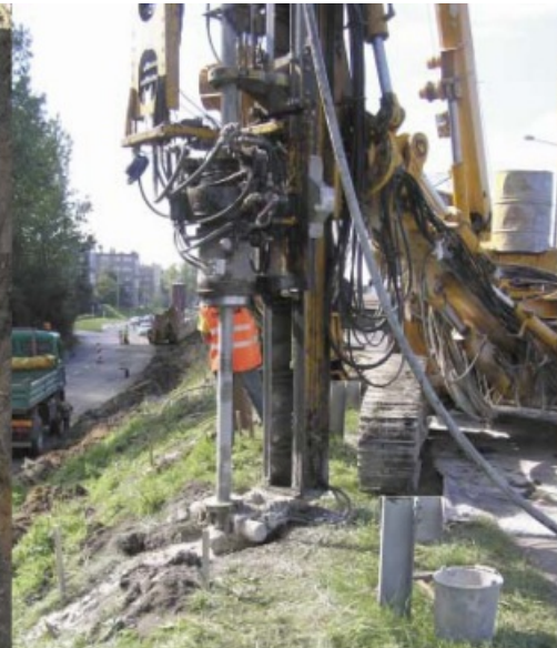
Fot. 2. Kolumny jet-grouting w skarpię zjazdu z wiaduktu
