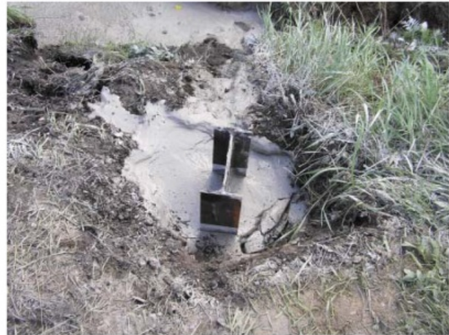
Fot. 4. Zbrojenie kolumny przed rozkuciem główki pala
