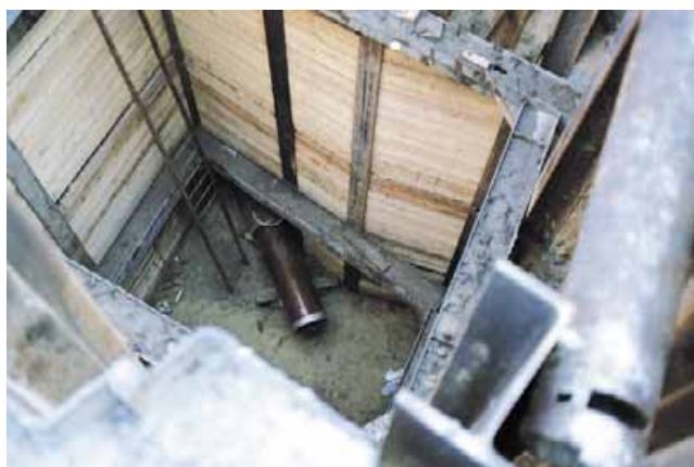
Fot. 3. Komora odbiorcza z widoczną rurą przewodową
