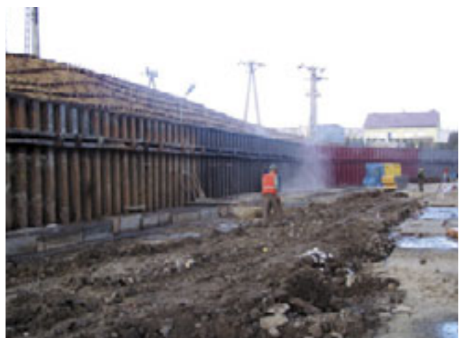
Fot. 5. Kolejne etapy nakładania powłoki antykorozyjnej i docelowej warstwy malarskiej
