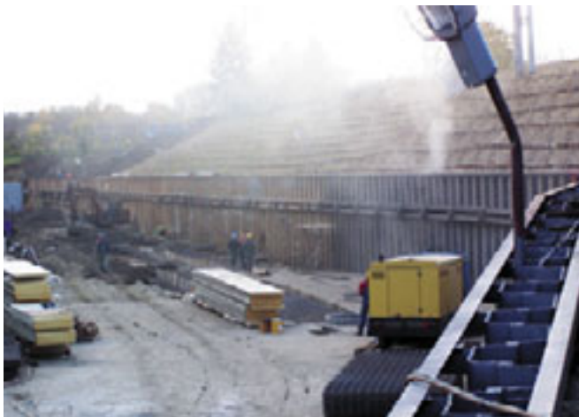
Fot. 3. Zakończony etap robót zasadniczych - uformowanie skarpy i wykonanie muru oporowego.
