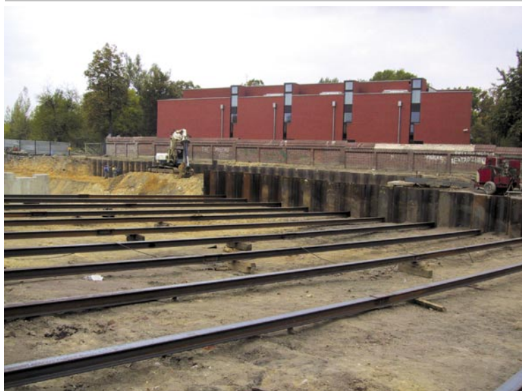
Ściana S4 od początku do załomu Z1 oraz część najazdu ściana S3
