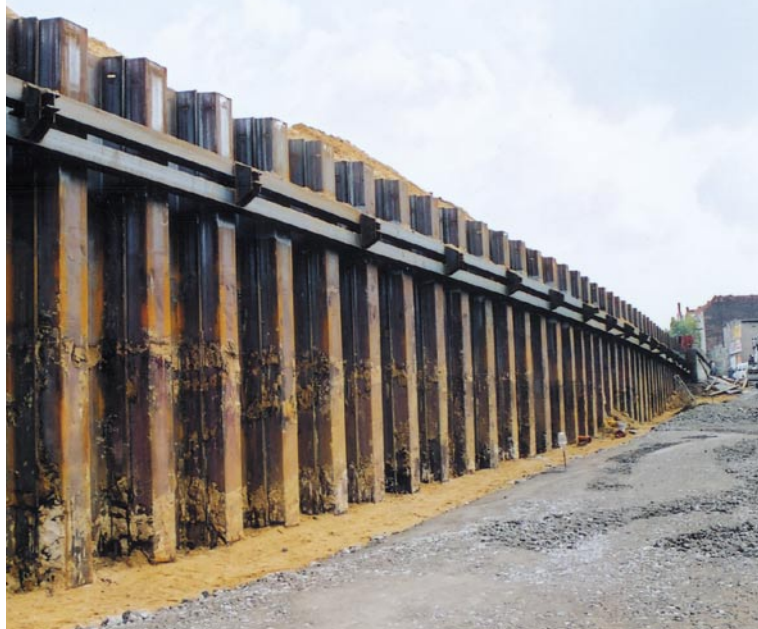
Ściana oporowa z grodzic PU20 wraz z kotwami gruntowymi Titan 52/26 wzdłuż budynku Radia Wanda
