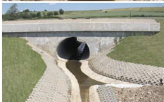
Fot. 3, 4. Przepusty o przekroju eliptycznym wykonane z elementów Multiplate
