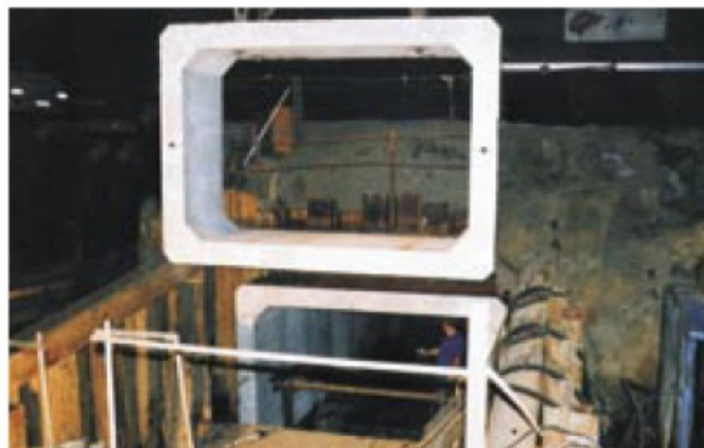
Fot. 1. Montaż ostatniego elementu skrzynkowego
