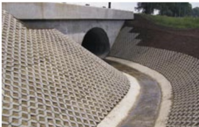
Fot. 5. Umocnienie rowu i skarpy w rejonie przepustu w km 453+326,35
