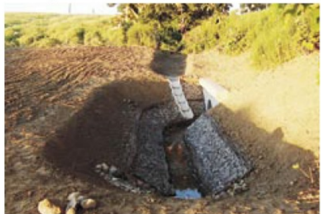
Fot. 7. Umocnienie rowu – kiszka faszynowa, paliki drewniane oraz gabiony kamienne
