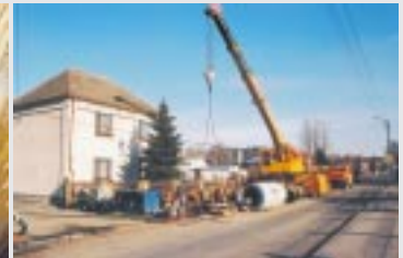
Fot 3,4 Budowa kolektora sanitarnego „Zb” DN 1000 o długości 527,0 mb w ul. Reymonta w Ostrowie Wielkopolskim.
