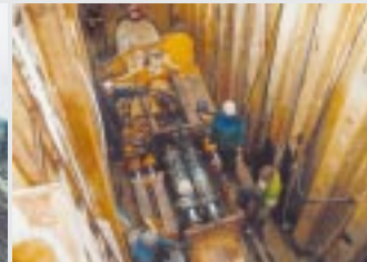
Fot 3,4 Budowa kolektora sanitarnego „Zb” DN 1000 o długości 527,0 mb w ul. Reymonta w Ostrowie Wielkopolskim.
