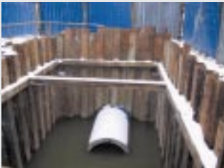
Fot 1 Budowa ulicy Nowotarskiej w Krakowie.
