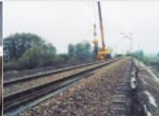
Fot 2 Likwidacja osuwiska na linii Kraków – Medyka.
