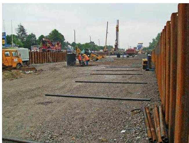
Fot. 5. Przygotowanie ściągnięć GONAR do montażu
