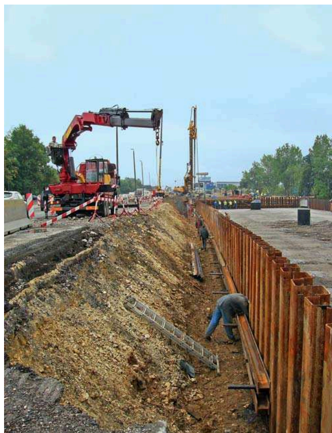
Fot. 2. Montaż kleszczy stalowych
