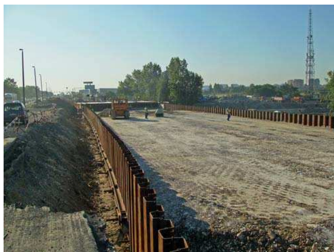
Fot. 4. Formowanie najazdu do nowobudowanego wiaduktu
