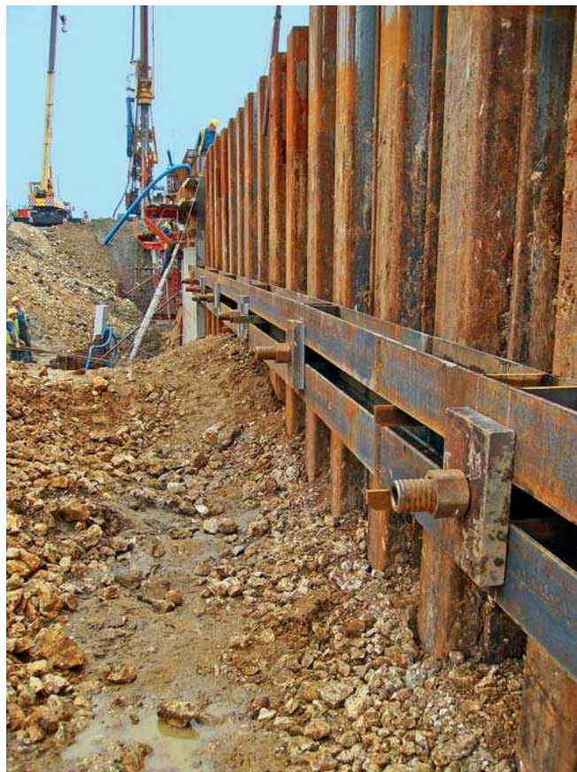
Fot. 3. Widok na konstrukcję spinającą
