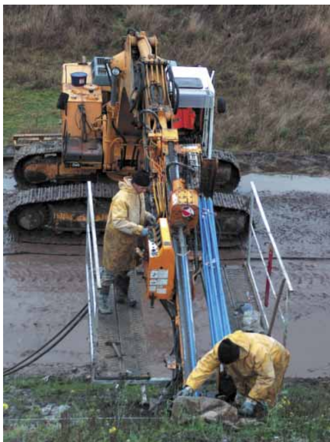
Fot. 3. Kotwiarka na bazie Liebherra
