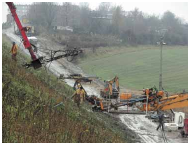
Fot. 4. Równoczesne wykonywanie gwoździ w dwóch pozimach
