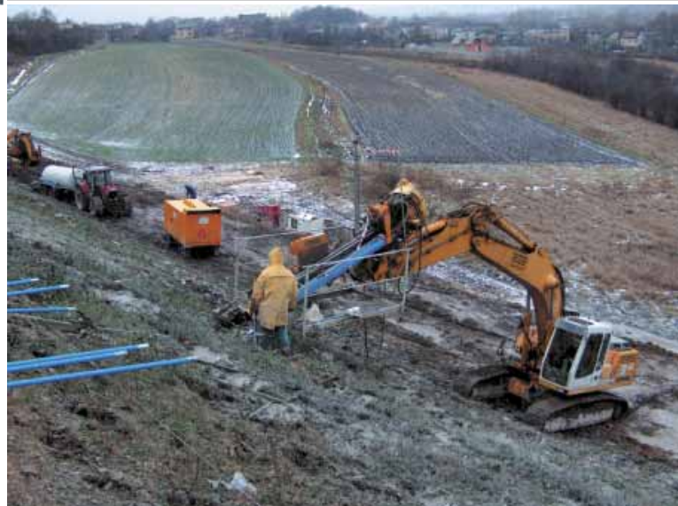
Fot. 1, Fot. 2. Budowa autostrady A4 w km 330+850 - 330+937, gwoździowanie skarpy
