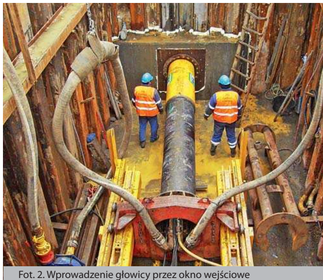
Fot. 2. Wprowadzenie głowicy przez okno wejściowe
