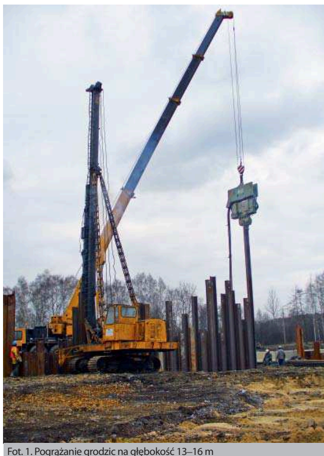
Fot. 1. Pograżanie grodzic na głębokość 13–16 m
