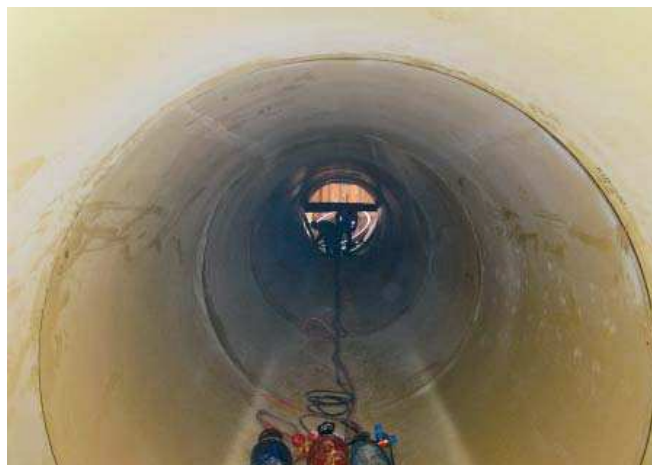
Fot. 3. Odcinek rur HOBAS DN 2000 ułożony wewnątrz rury stalowej
