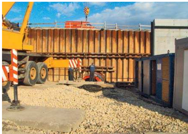
Fot. 1. Zabezpieczenie DK86 - obudowa komory startowej
