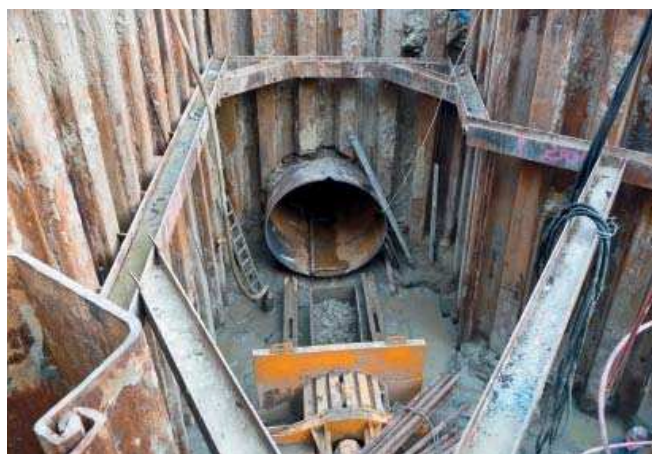
Fot. 2. Obudowa wykopu komory K25
