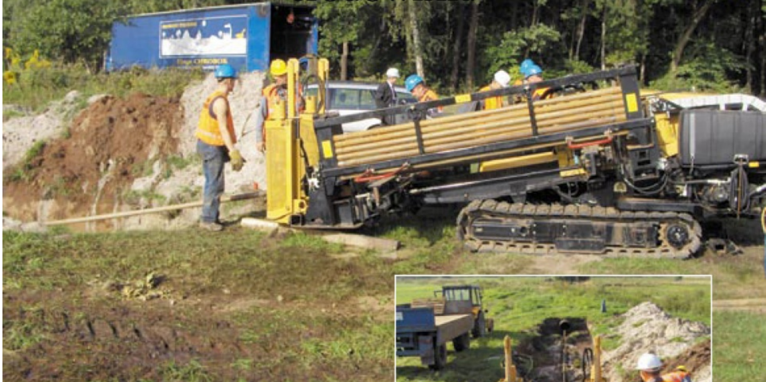
Fot. 1. Prowadzenie żerdzi pilotażowej
