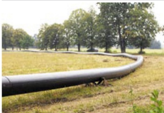
Fot. 7. Przygotowany do wprowadzenia odcinek rurociągu
