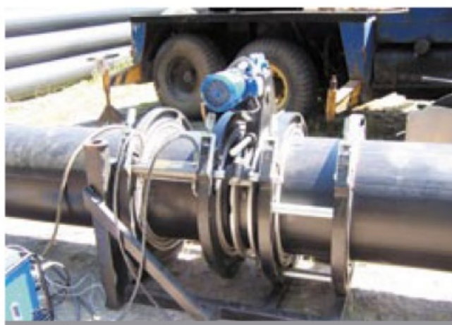
Fot. 6. Proces zgrzewania
