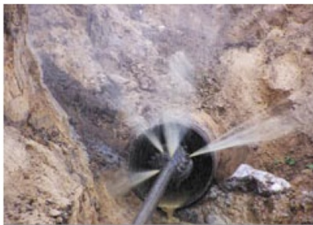
Fot. 8. Głowica podająca bentonit
