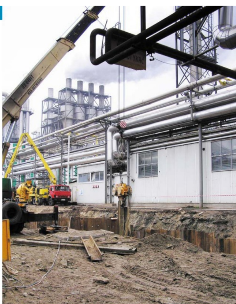
Fot. 1. Ścianka w sąsiedztwie czynnej hali produkcyjnej i ciągów technologicznych CPS 42 do produkcji płyt wiórowych w Zakładach KRONOSPAN w Szczecinku
