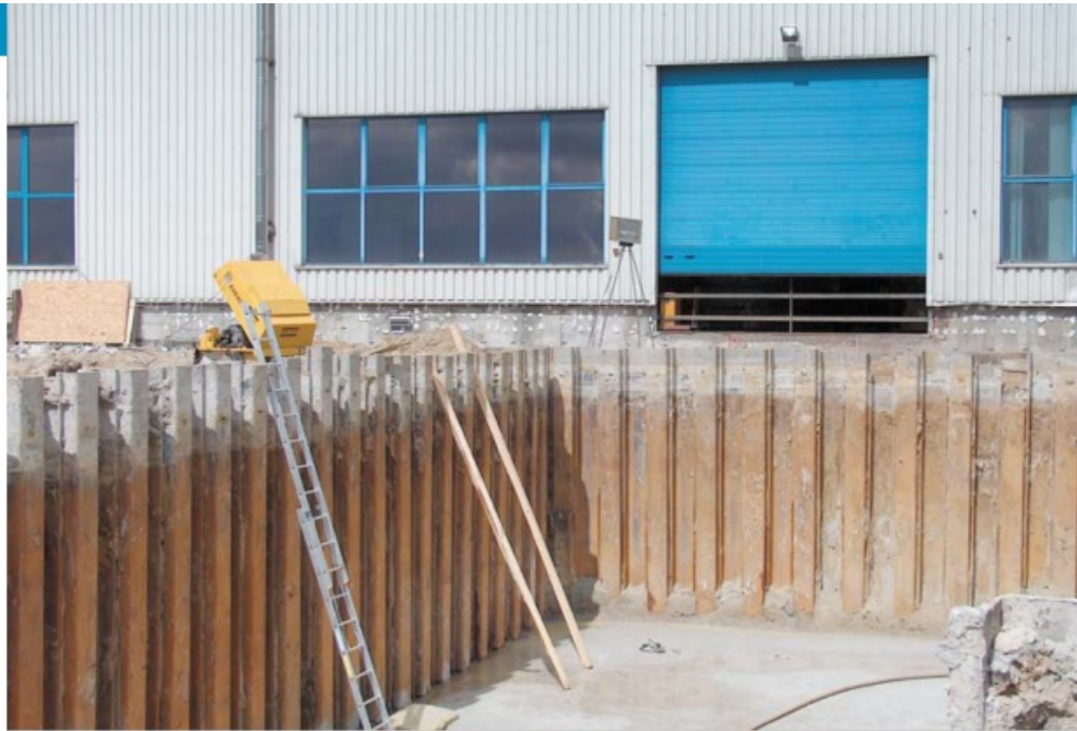
Fot. 3. Ścianka szczelna i palisada jet-grouting na terenie Zakładu Produkcyjnego Kirchhoff Polska Sp. z o.o. przy ul. Wojska Polskiego 3 w Mielcu
