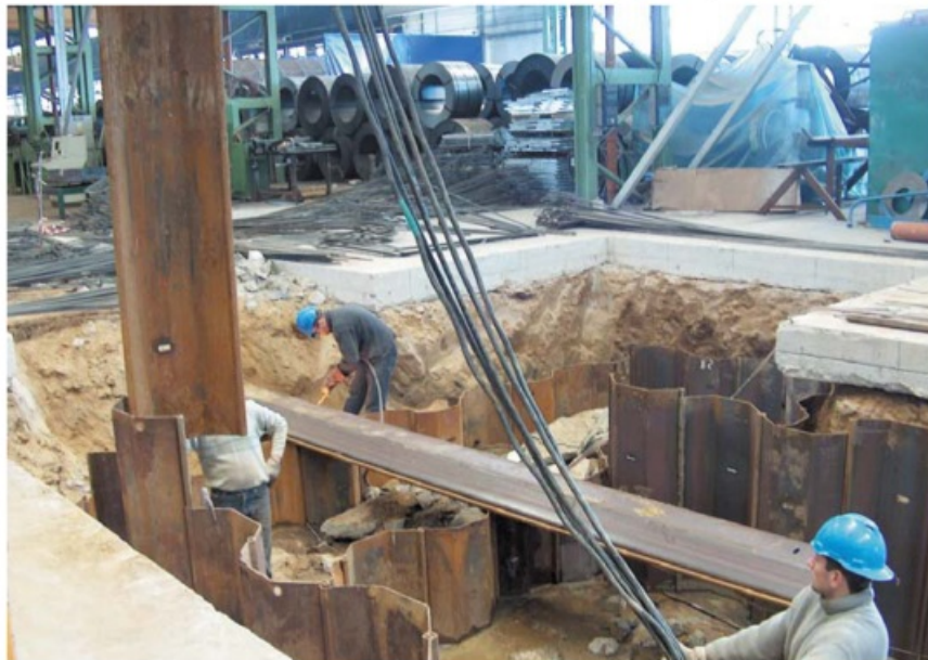
Fot. 4. Zabezpieczenie wykopu pod fundament linii cięcia blach wewnątrz hali Polimex Mostostal Siedlce przy ul. Terespolskiej 12 w Siedlcach
