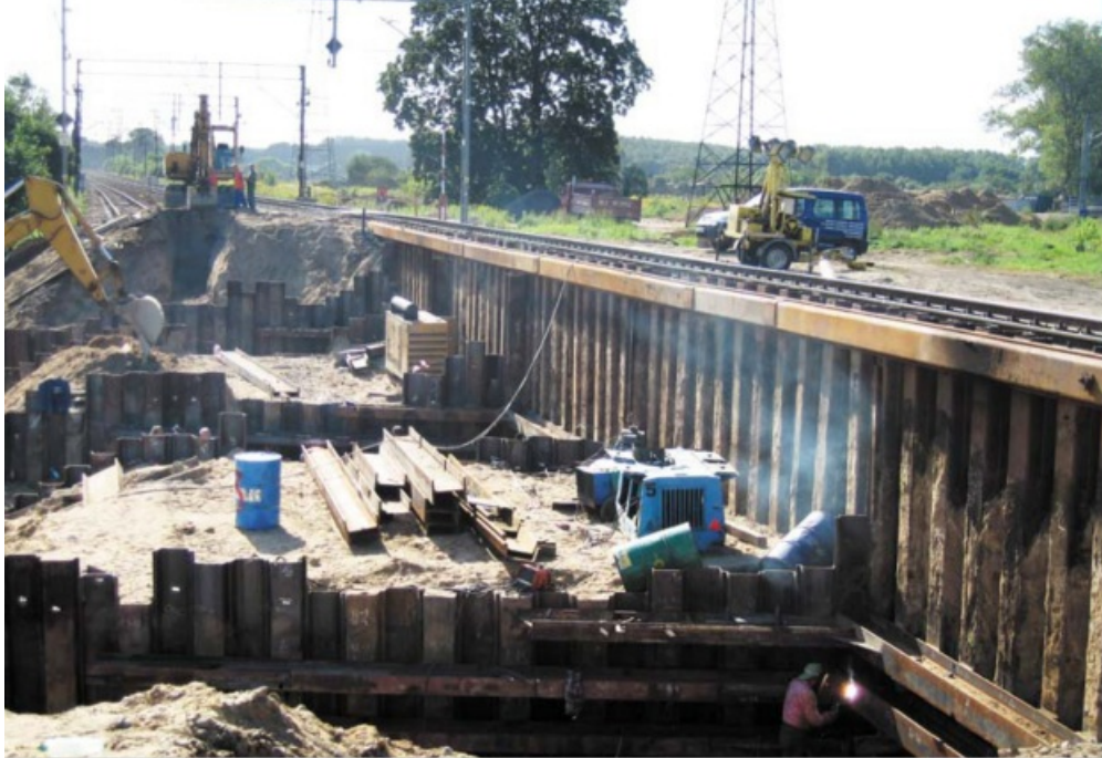
Fot. 5. Zabezpieczenie czynnego torowiska grodzicami dł. 16 m - Budowa ul. Sielskiej w Olsztynie
