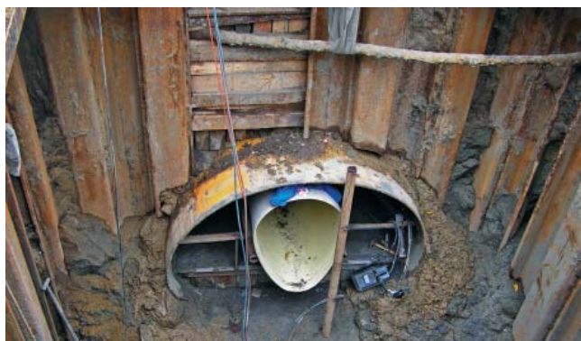
Fot. 1. Montaż rury medialnej GRP 1200-800 w rurze przewiertowej
