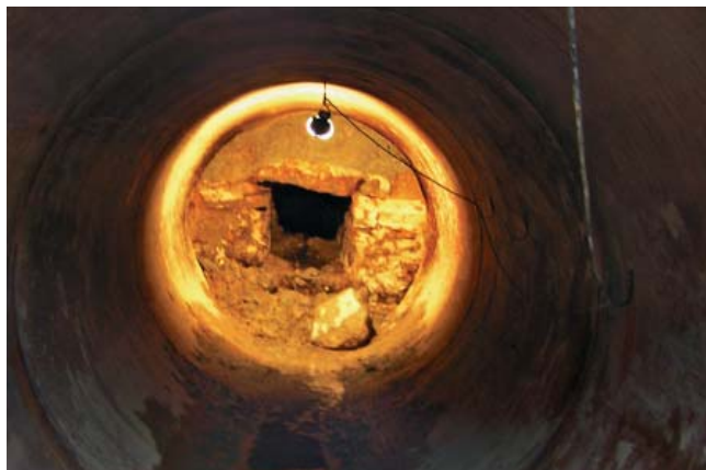
Fot. 2. Istniejący kanał wewnątrz rury stalowej
