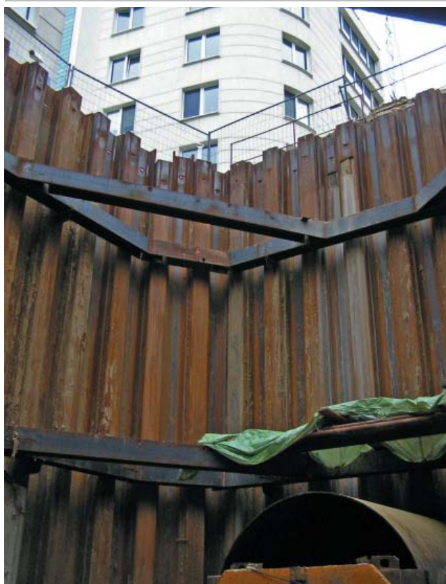
Fot. 6. Komora nadawcza w sąsiedztwie istniejącej zabudowy
