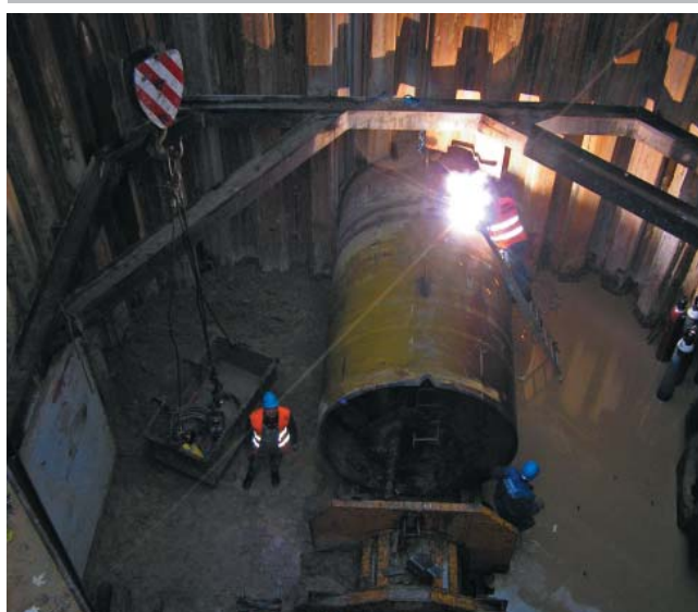
Fot. 5. Spawanie kolejnego odcinka rury stalowej
