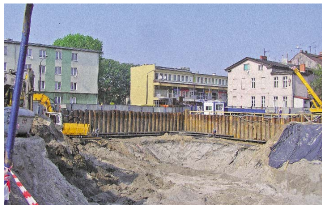
Fot. 3. Montaż podłużnic stalowych - Słupsk
