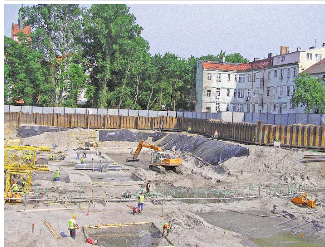
Fot. 4. Przypora ziemna w pierwszej fazie wykopu - Słupsk
