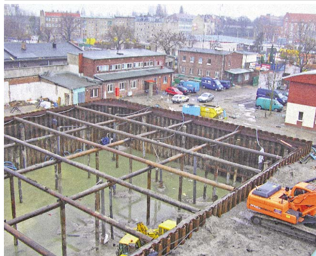
Fot. 5. Siatka rozporc obudowy zbiornika retencyjnego w Szczecinie
