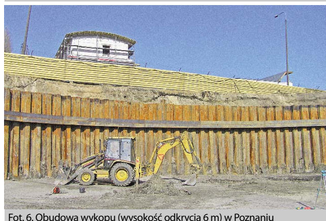
Fot. 6. Obudowa wykopu (wysokość odkrycia 6 m) w Poznaniu
