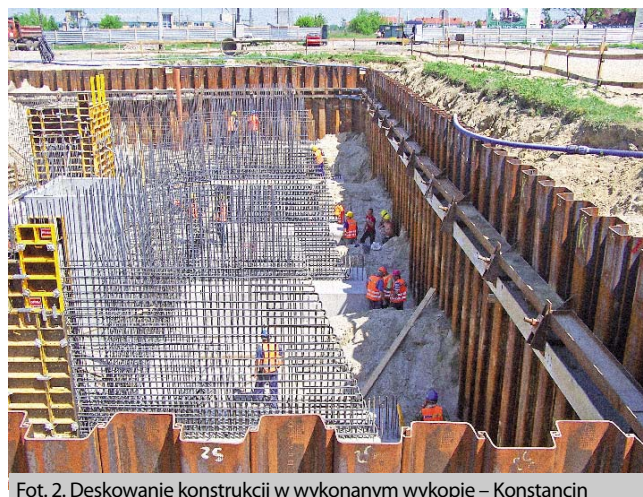
Fot. 2. Deskowanie konstrukcji w wykonanym wykopie – Konstancin
