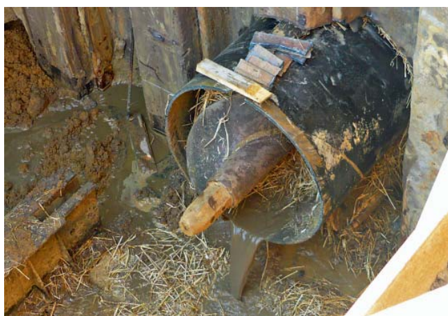
Fot. 1. | Wyjście przecisku do komory odbiorczej
