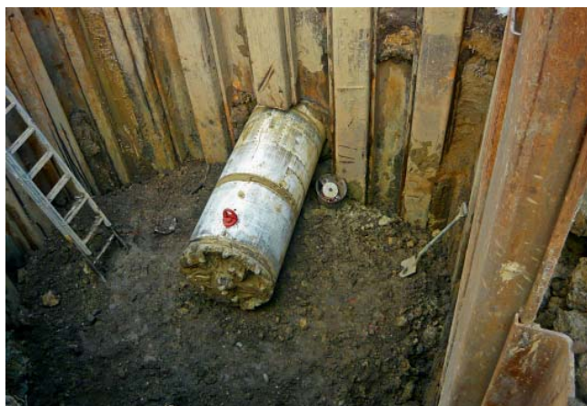
Fot. 2. | Głowica Herrenknechta
