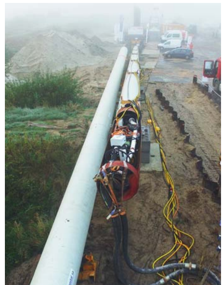
FOT. 3. Uzbrojenie (pompa tunelowa) końca instalowanej rury
