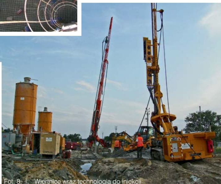
Fot. 8. | Wiertnice wraz technologią do iniekcji
