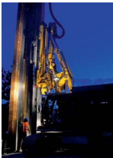
Fot. 10. | Statyczne pogrążanie grodzic
