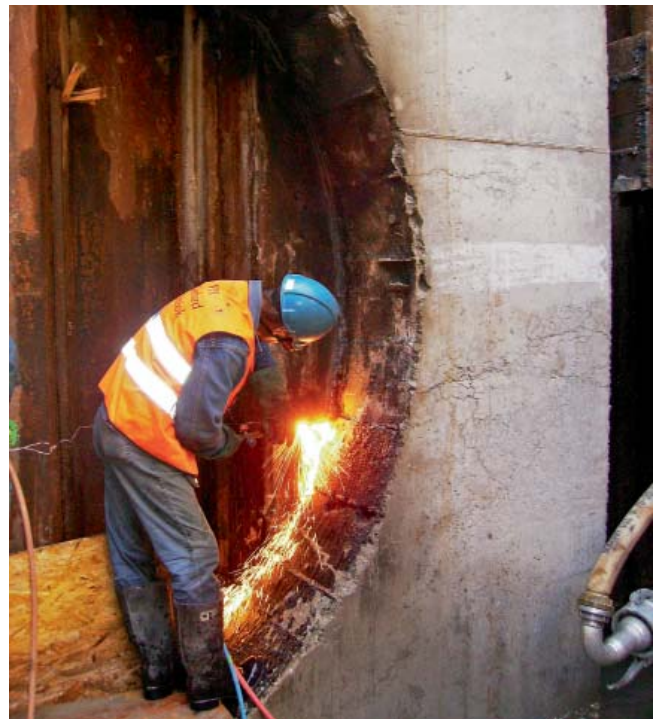
Fot. 5. | Wypalanie otworu w ścianie stalowej
