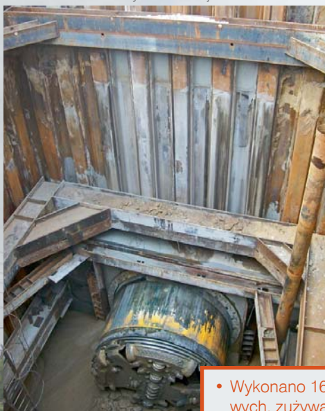
Fot. 2. | Moment wejścia głowicy mikrotunelowej do komory odbiorczej
