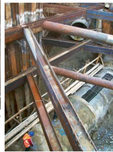
Fot. 3. | Komora pośrednia przewiercona mikrotunelom ↑ po wbudowaniu studni rewizyjnej
