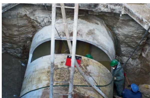
Fot. 6. | Ściana z przesłony jet-grouting ↓
