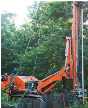
Fot. 9. | Podwiercanie z użyciem ciśnienia dla ułatwienia pogrążania grodzic
