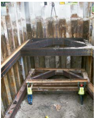
Fot. 11. | Ramy i rozpory stalowe
