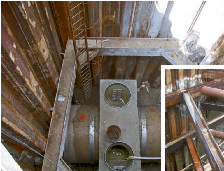
Fot. 3. | Komora pośrednia przewiercona mikrotunelom ↑ po wbudowaniu studni rewizyjnej
