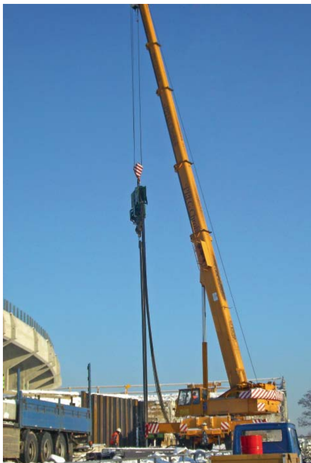
Fot. 4. | Wbijanie grodzic stalowych
